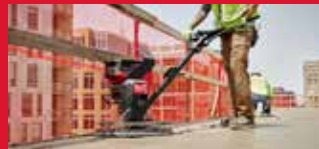
FAS 2 GJUTNING & FINISH
